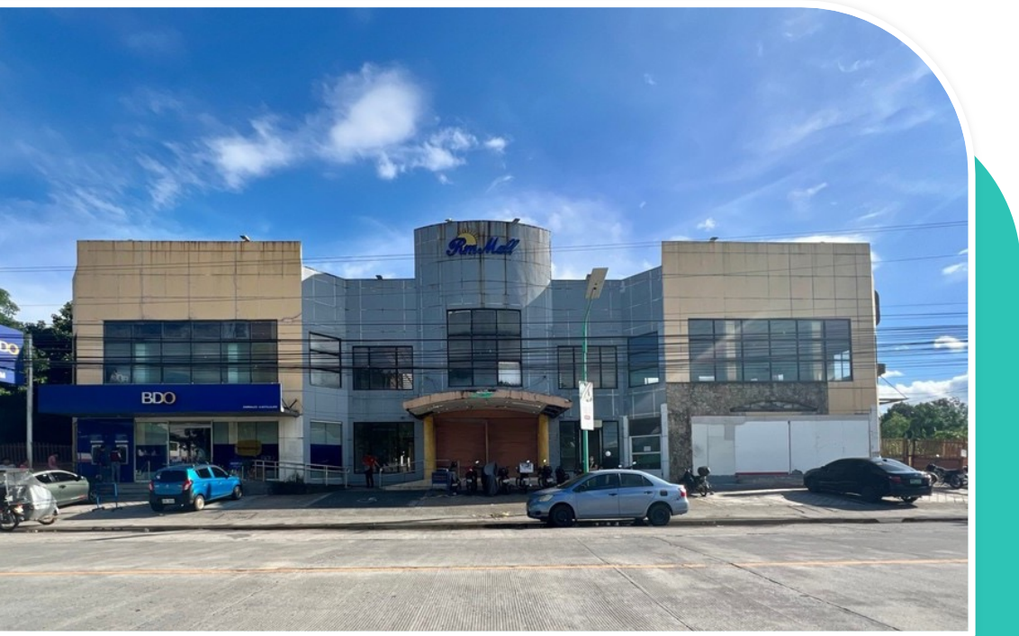
Castillejos Commons – Pre-Renovation
